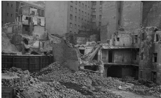
Die Abrissfläche Kaunitzgasse 15. Bildquelle BM Mariahilf
