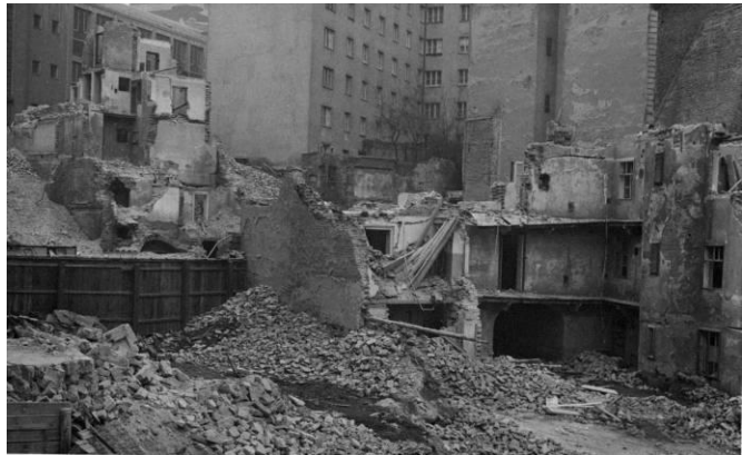
Die Abrissfläche Kaunitzgasse 15. Bildquelle BM Mariahilf
