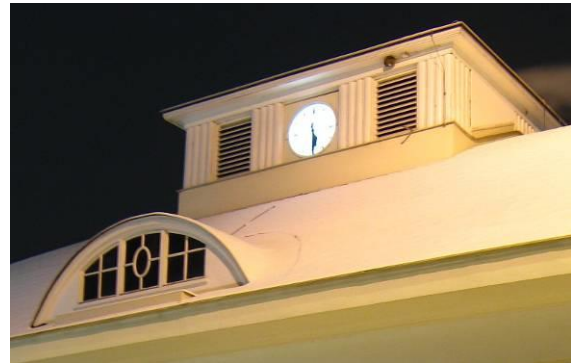
Die Uhr am renovierten Marktamtsgebäude Naschmarkt Bildquelle: Panoramio 14.1.2009
