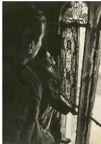
Einsetzen des fertigen Feldes
