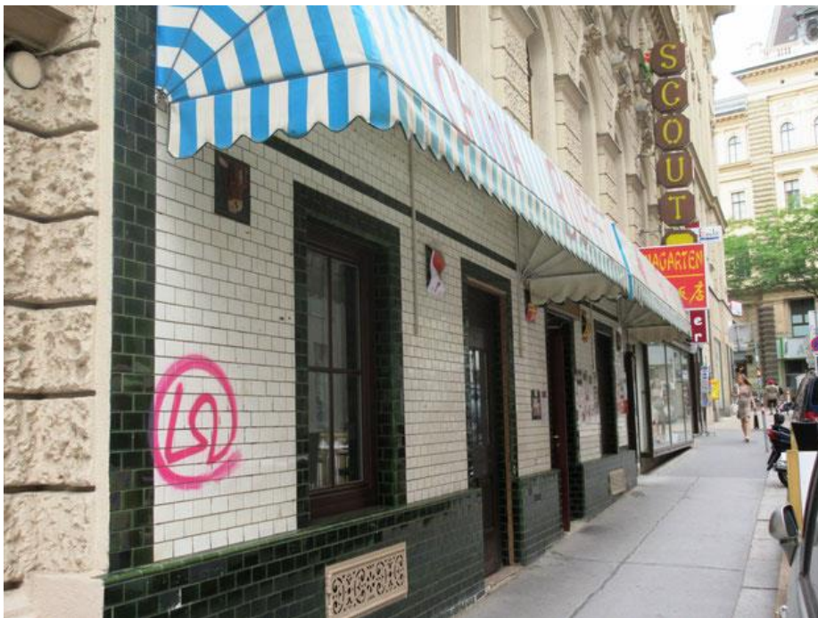
Abb. 15. Geschäftsfassade Capistrangasse 3 – Foto: Autor (2018)
